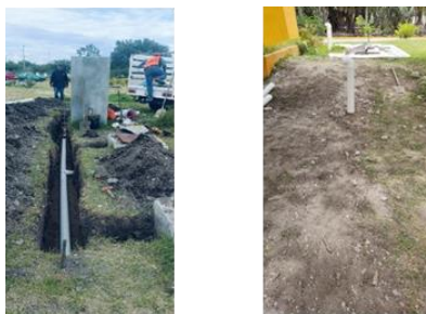
Ilustración 22. Desarrollo de sistemas de captación de aguas pluviales
