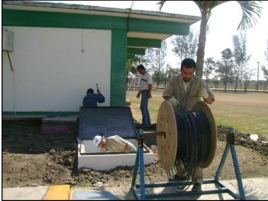
Figura10. I.T. Altamira. Instalación de fibra óptica
